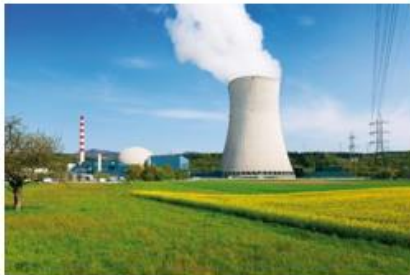
Gösgen: KKG, 1035 MWe, 1979
