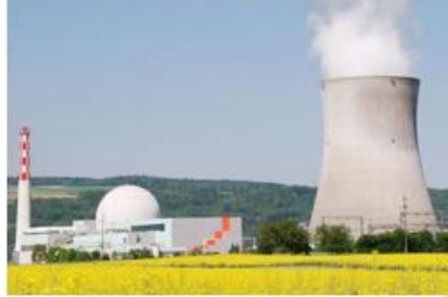
Leibstadt: KKL, 1285 MWe, 1984
