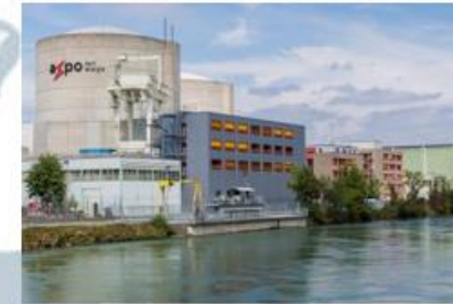
Beznau: KKB I, 380 MWe, 1969 KKB II, 380 MWe, 1971
