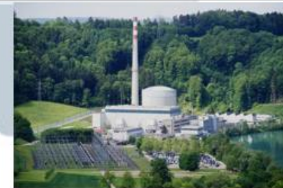
Mühleberg: KKM, 390 MWe, 1972-2019
